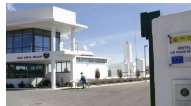
La entrada a las instalaciones de la desaladora de Santa Eulària. / VICENT MARI
