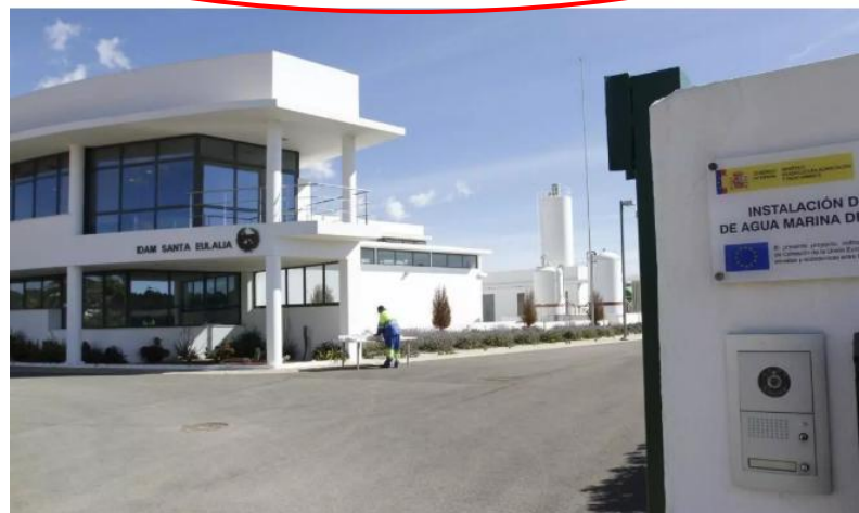
a entrada a las instalaciones de la desaladora de Santa Eulària. / VICENT MARI
